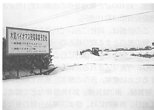
木質バイオマス発電所の建設予定地(平川市内)
