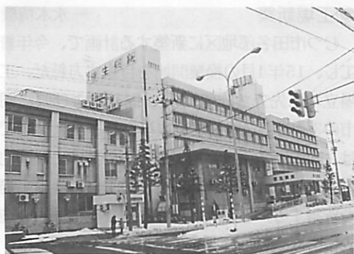
老朽化が進行している健生病院
