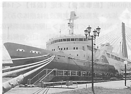
保存・活用に向け船体改修工事を行う八甲田丸
