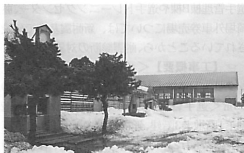
校舎耐震補強および屋内運動場改築を行う西田沢小学校
