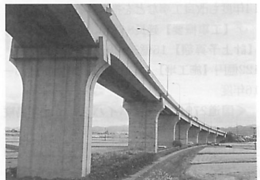
AMシステムで橋梁を効率的に維持管理(写真はエアポート大橋)
