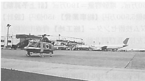
エプロンの舗装補修を実施する青森空港
