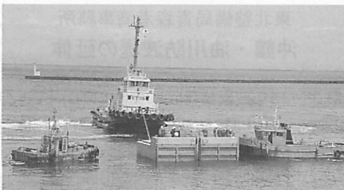
青森港内を曳航される油川地区東防波堤本体ケーソン
