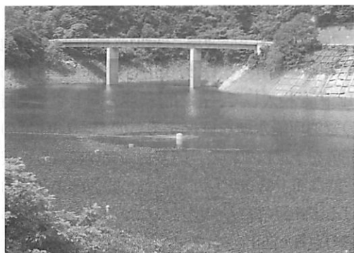
水質保全のため設置されたダム湖に設置された曝気装置(中央)
