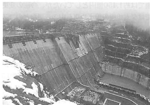
今秋に本体コンクリート打設が完了する津軽ダム(13年11月撮影)
